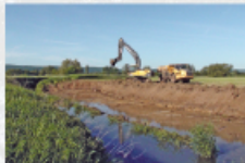
(1) Die einst begradigte Aue bekommt wieder einen naturnahen Flussbogen.
